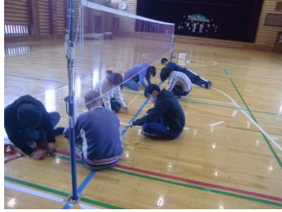
体育館ラインテープ補修
